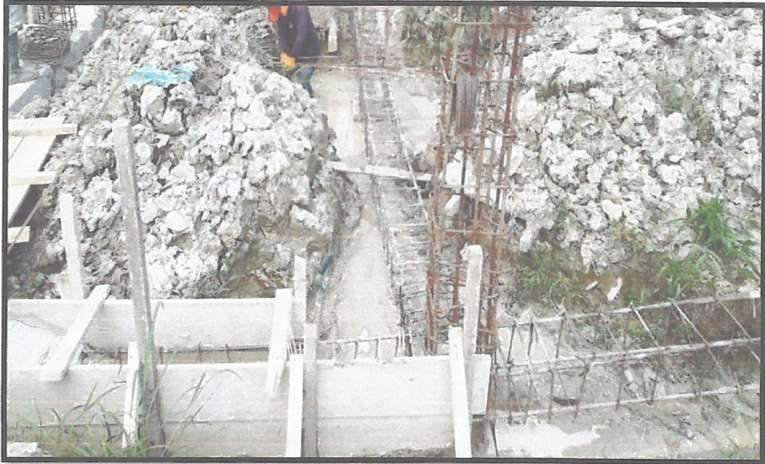
IMAGEN N°01: EN LA IMAGEN SE MUESTRA TRABAJOS DE EXCAVACIÓN DE ZANJA PARA VIGA DE CIMENTACIÓN.
