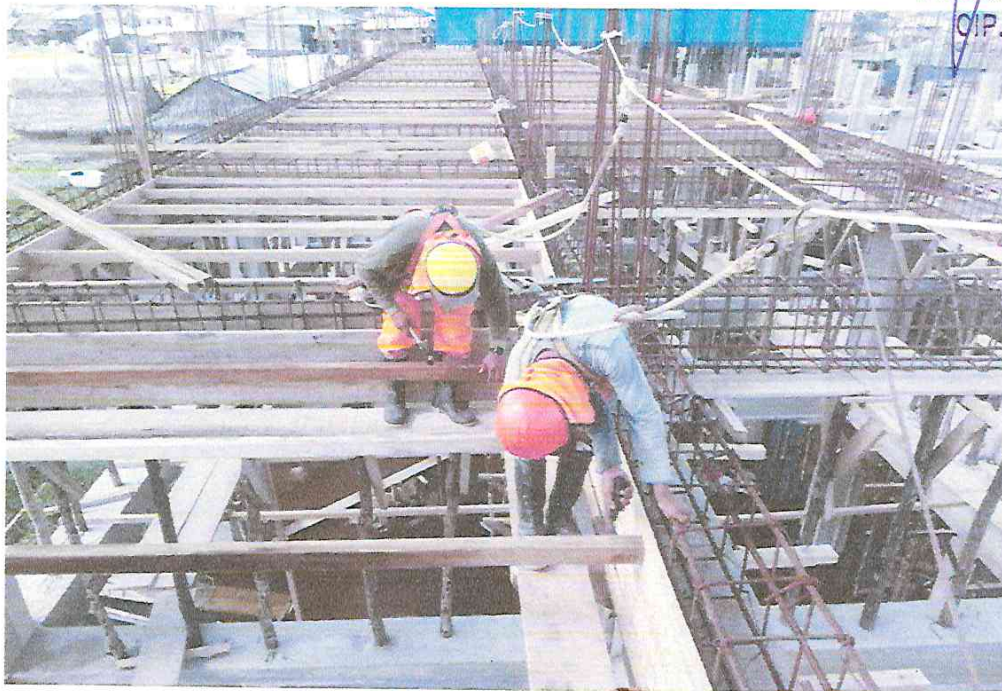
FOTO N°02 – TRABAJOS DE ENCOFRADO CON LINEA DE VIDA
