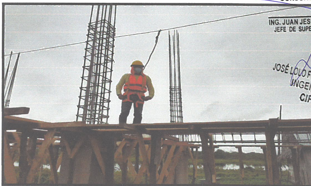
IMAGEN N°07: SE OBSERVA TRABAJOS DE ENCOFRADOS PARA VIGAS DE MORTERO F'C=210 KG/CM2
