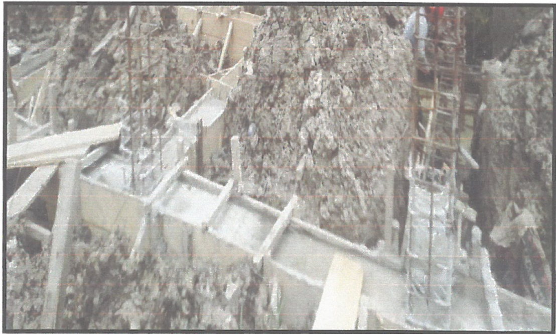
IMAGEN N°02: SE MUESTRA VACEADO DE VIGAS DE CIMENTACION CON MORTERO F'C=210KG/CM2
