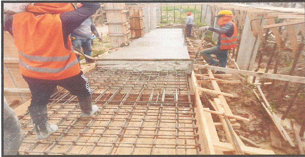
IMAGEN N°05: SE PUEDE OBSERVAR LOS TRABAJOS DE VACEADO DE MORTERO F'C=210 KG/CM2 (EN RAMPA)
