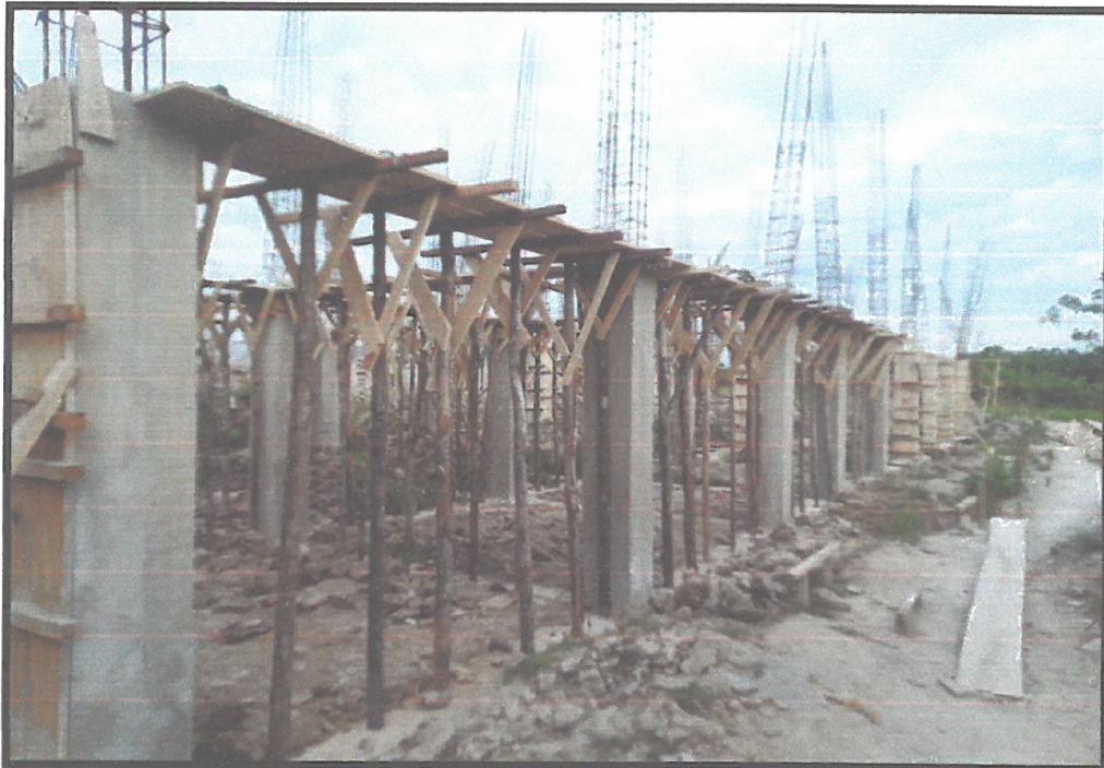
IMAGEN N°07: SE OBSERVA TRABAJOS DE ENCOFRADOS PARA VIGAS DE MORTERO F'C=210 KG/CM2
