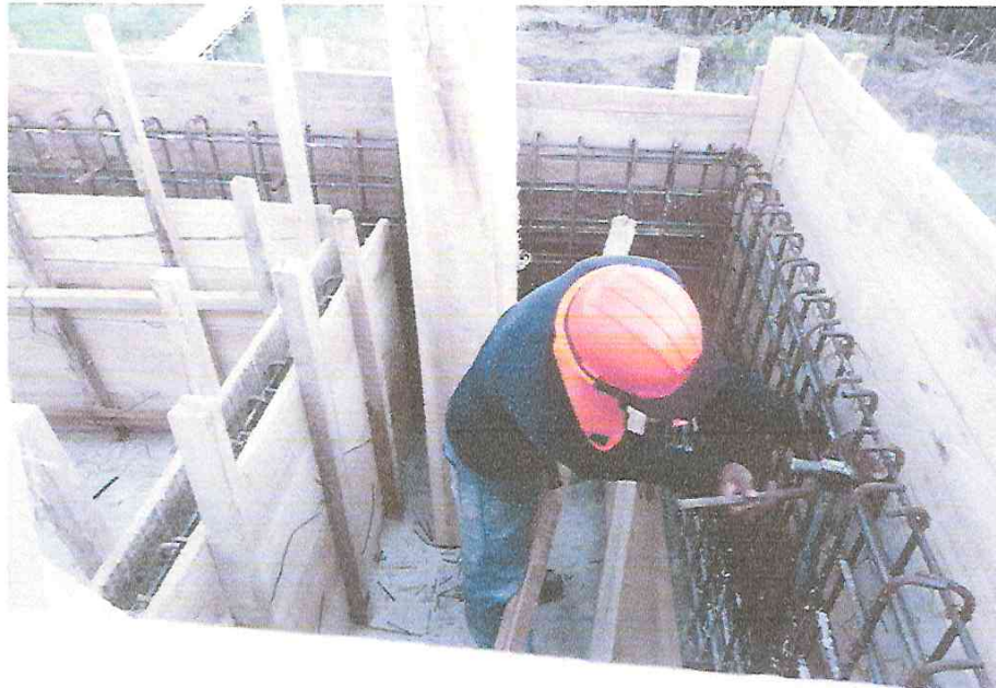
FOTO N°02 – TRABAJOS DE ENCOFRADO CON LINEA DE VIDA
