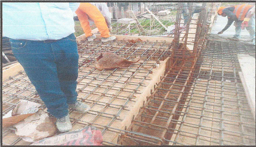
IMAGEN N°04: EN LA FOTO, SE MUESTRA LA HABILITACION DEL ACERO DE REFUERZO D=1/2" FY=4,200 KG/CM2 EN LA RAMPA DE ACCESO
