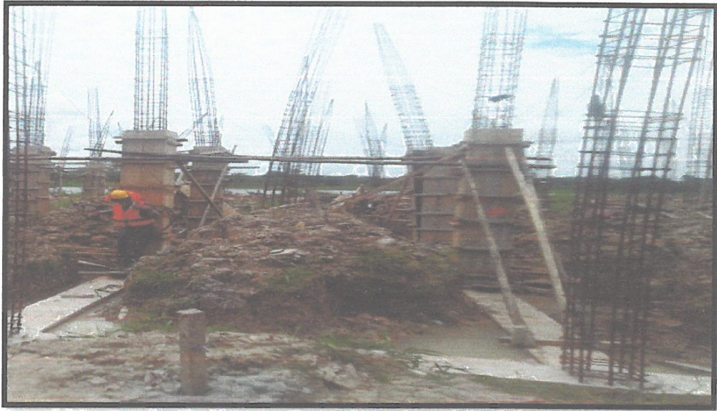
IMAGEN N°05: SE OBSERVA TRABAJOS DE ENCOFRADO DE COMUNAS F'C=210KG/CM2
