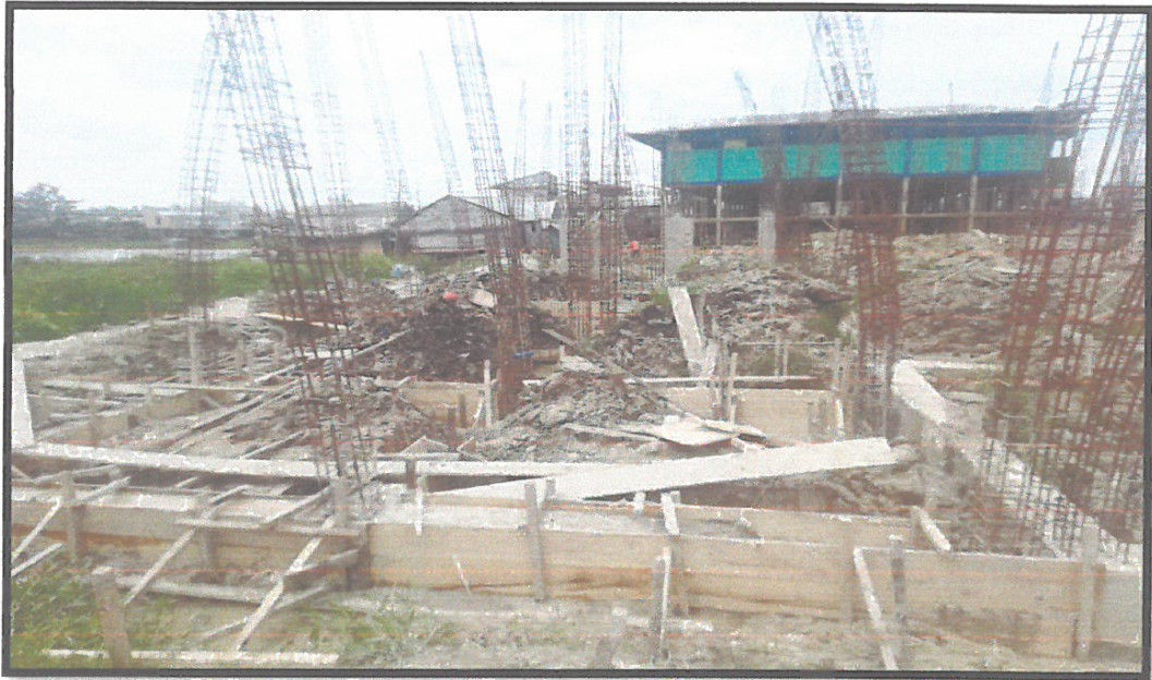
IMAGEN N°03: EN LA IMAGEN SE VISUALIZA TRABAJOS DE ENCOFRADO DE VIGAS DE CIMENTACION
