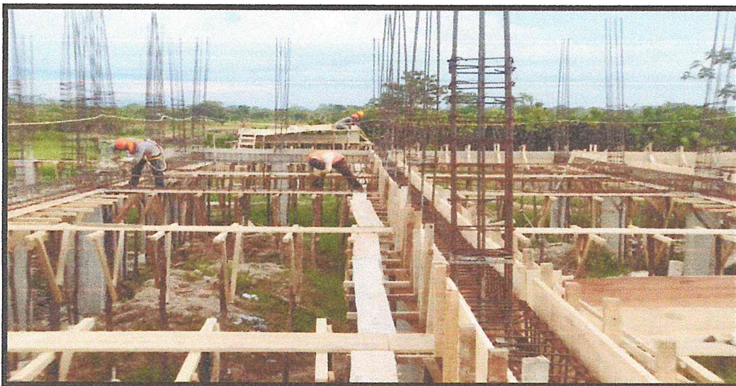
IMAGEN N°10: SE MUESTRA TRABAJOS DE ENCOFRADO DE VIGAS Y HABILITACION DEL ACERO DE REFUERZO.
