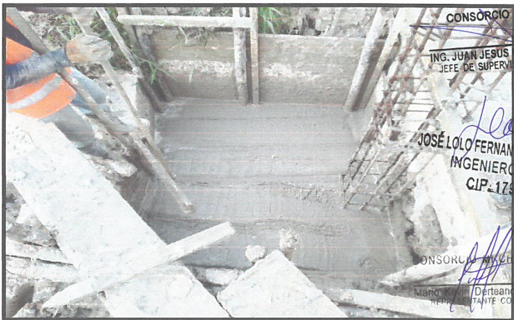
IMAGEN N°10: EN LA FOTO TRABAJOS DE VACEADO DE MORTERO F'C=210 KG/CM2 EN ZAPATAS
