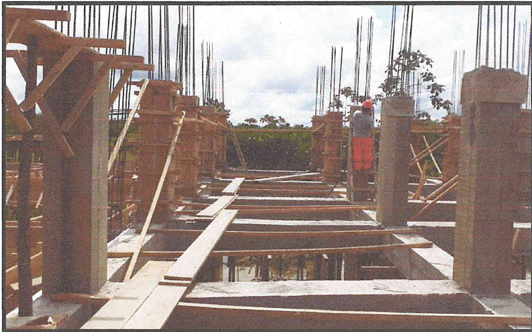
IMAGEN N°01: EN LA IMAGEN SE MUESTRA TRABAJOS DE ENCOFRADO Y DESENCOFRADO DE COLUMNAS.
