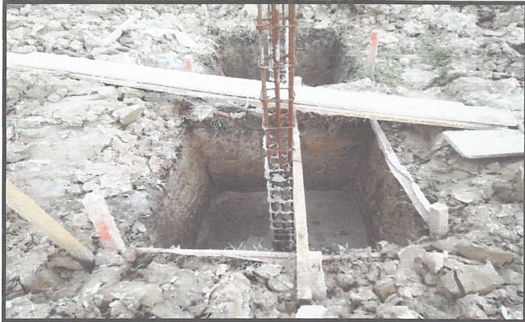
IMAGEN N°09: SE MUESTRA TRABAJOS DE VACEADO DE MORTERO F'C=210 KG/CM2 EN ZAPATAS
